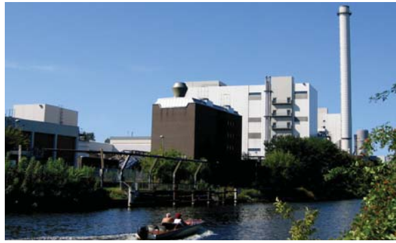
Das Heizkraftwerk Rudow am Teltowkanal lieferte fast 40 Jahre lang Strom und Wärme für die Gropiusstadt - bald wird es Einfamilienhäusern und einem Sporthafen weichen.
